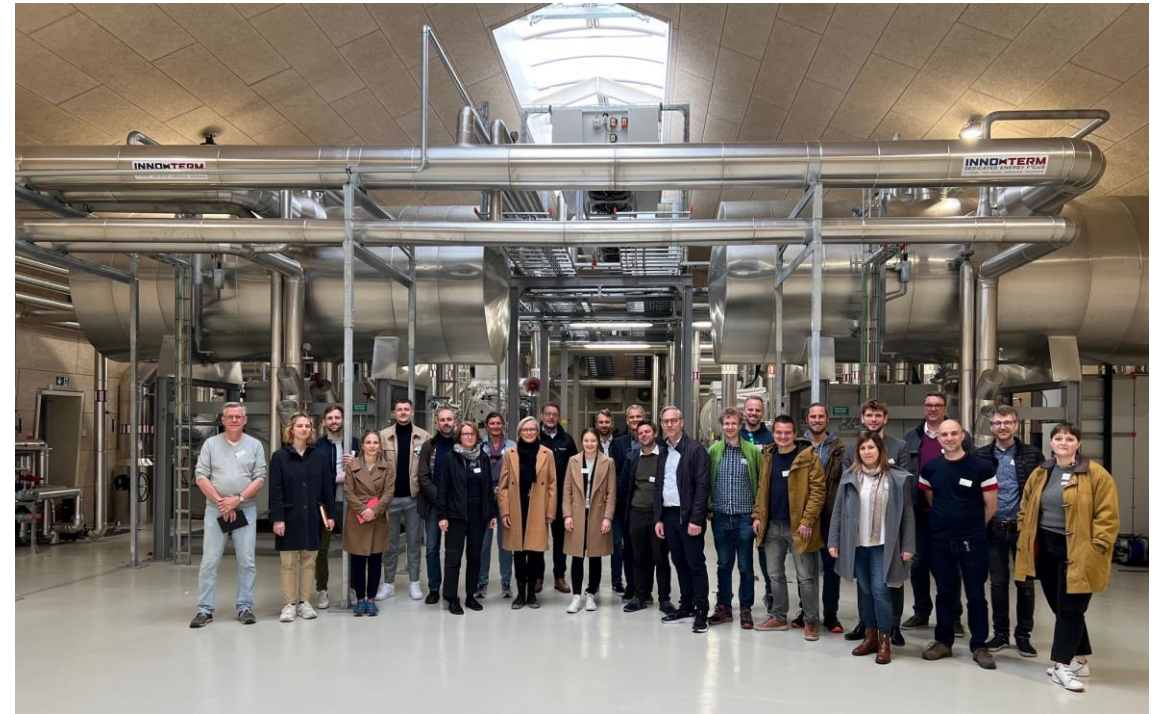
Teilnehmer in Großwärmepumpe 7,8 MW im Wärmekraftwerk Assens
